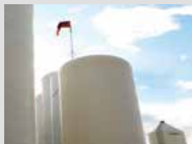
SURVEILLANCE DE RÉSERVOIR
